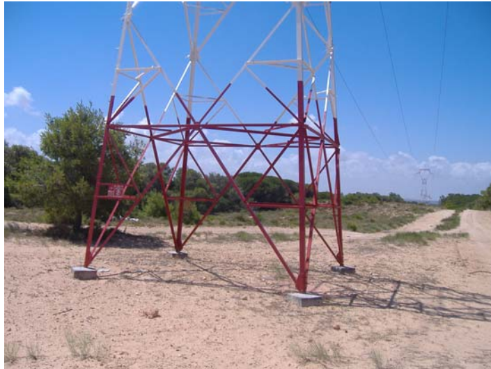
Figure 4: Fondations réalisées pour la fixation des pylônes
