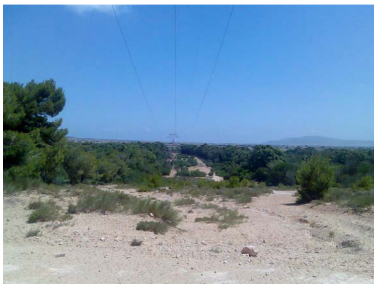
Figure 7 : Passage de la ligne HT à travers le couloir coupe feu de la forêt artificielle de Dar Chichou
