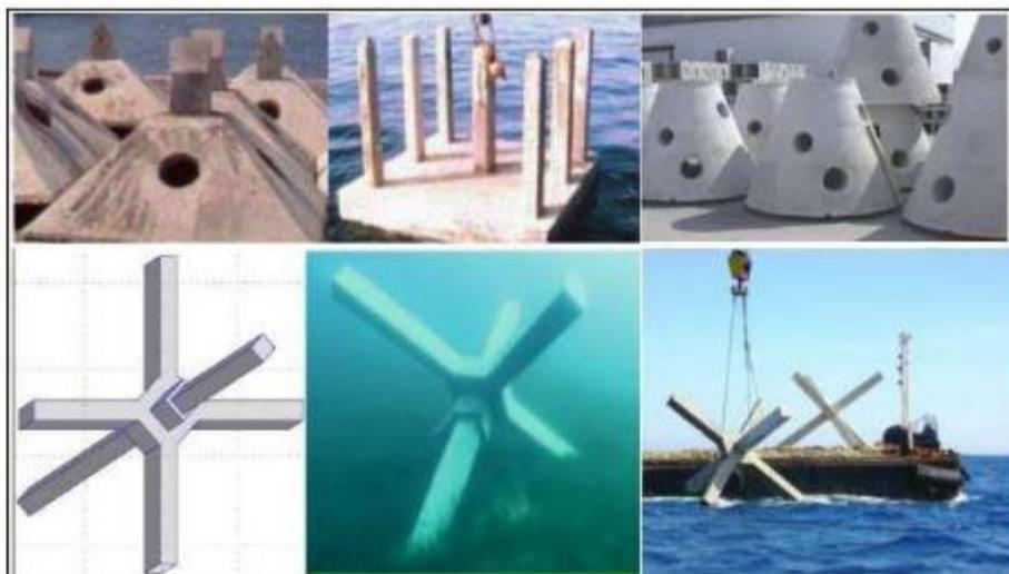
Figure 4.19: Exemple de dissuasion pour la protection des câbles sous-marins
