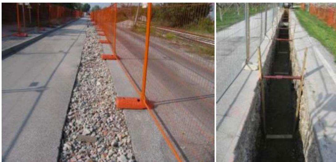
**Figure 4 . 5: Exemple d'installation de câble sur une route goudronnée**
