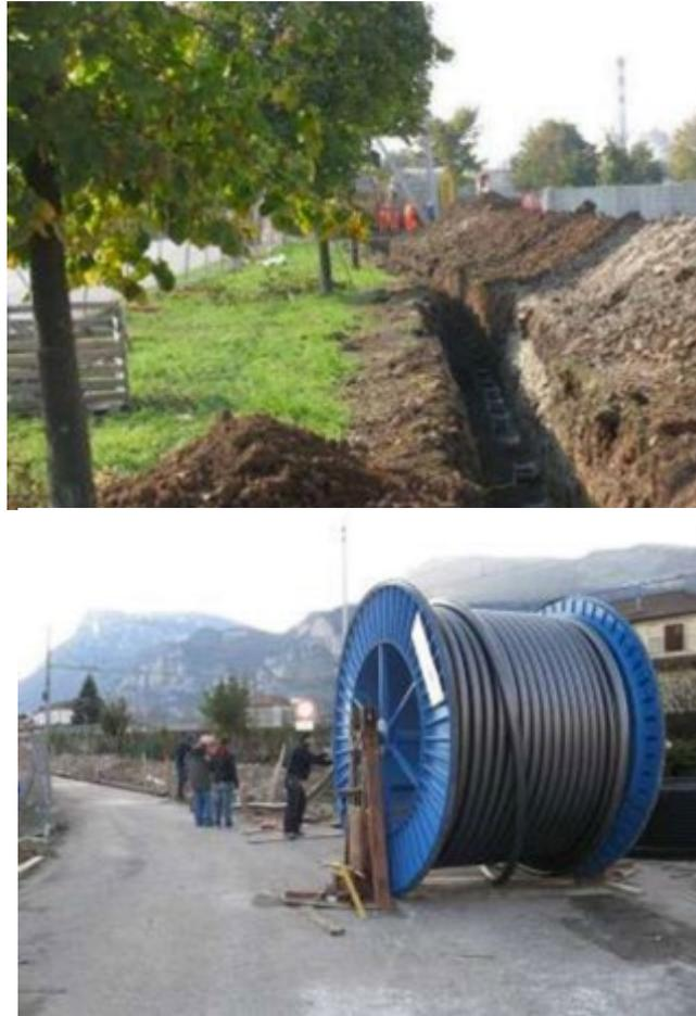
**Figure 4 . 6: Exemple de pose de câble en tranchée**
