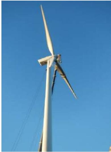
Figure 28 : Exemple de montage de pale d'éolienne
