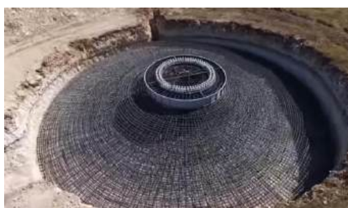
Figure 23 : Semelle préparée pour le coulage du béton
