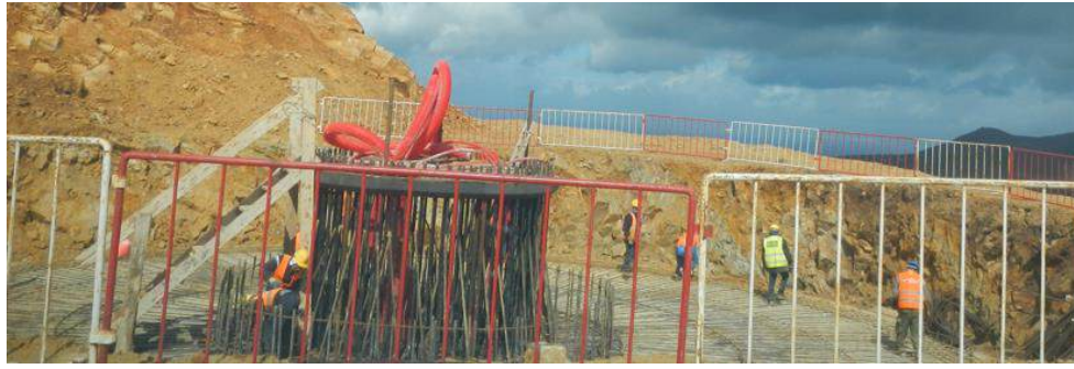
Figure 24 : Processus de coulage du béton après ferrailage
