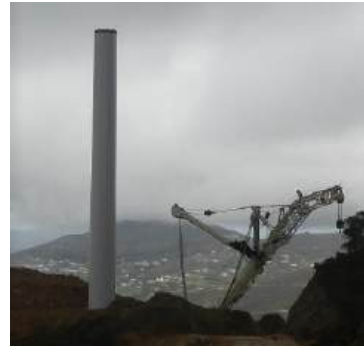
Montage des éléments de la tour
