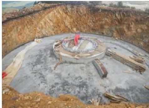
Figure 25 : Remplissage de la fondation
