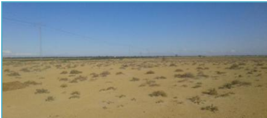
Figure 74 : Ligne électrique de moyenne tension près du site du poste de Zaafrana.
