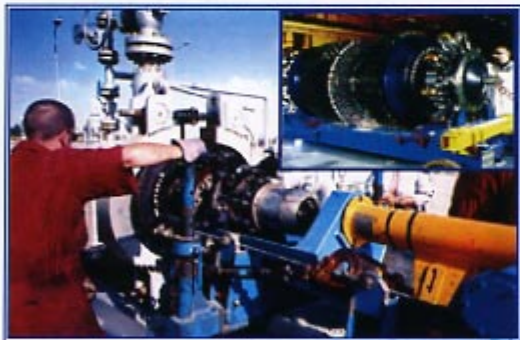
Lancement du racleur MFL dans la conduite Mornag-Radès
