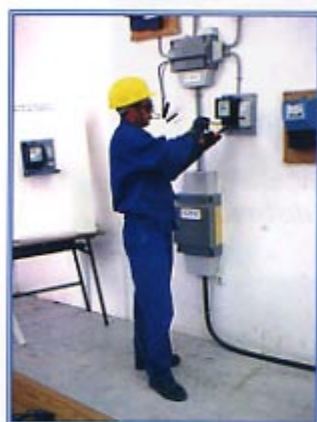
Photo 5 : Travail au contact en BT
