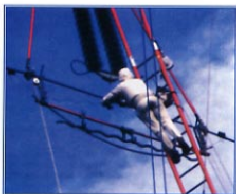
Photo 4 : Travail au potentiel en HT
