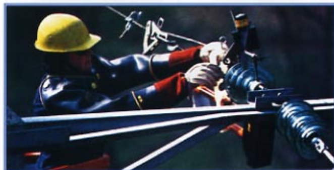
Photo 2 : Travail au contact en MT
