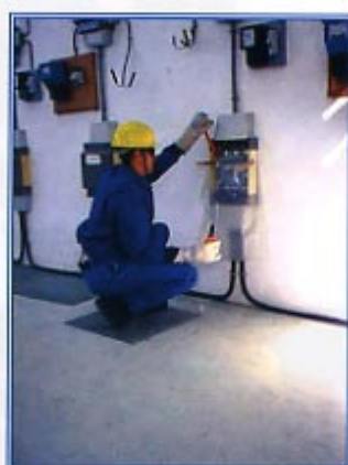
Photo 5 : Travail au contact en BT
