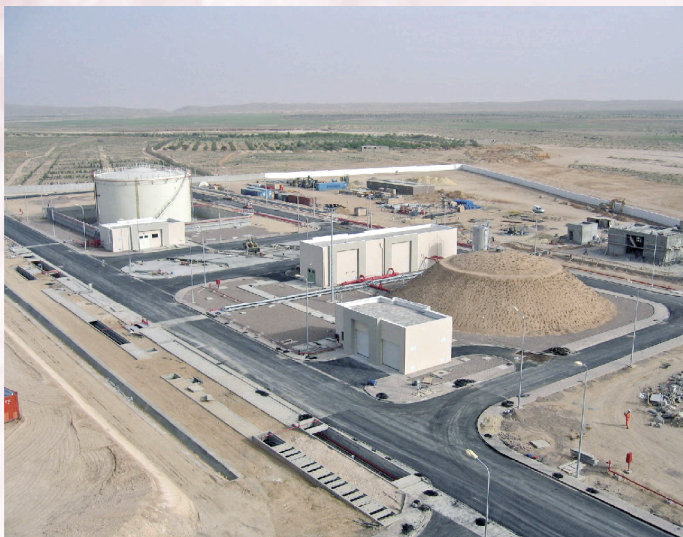
La centrale de Feriana mise en service en juin 2005
