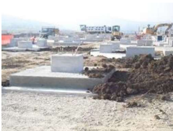
Figure 4 . 1: Fondations d'équipement monocœur
