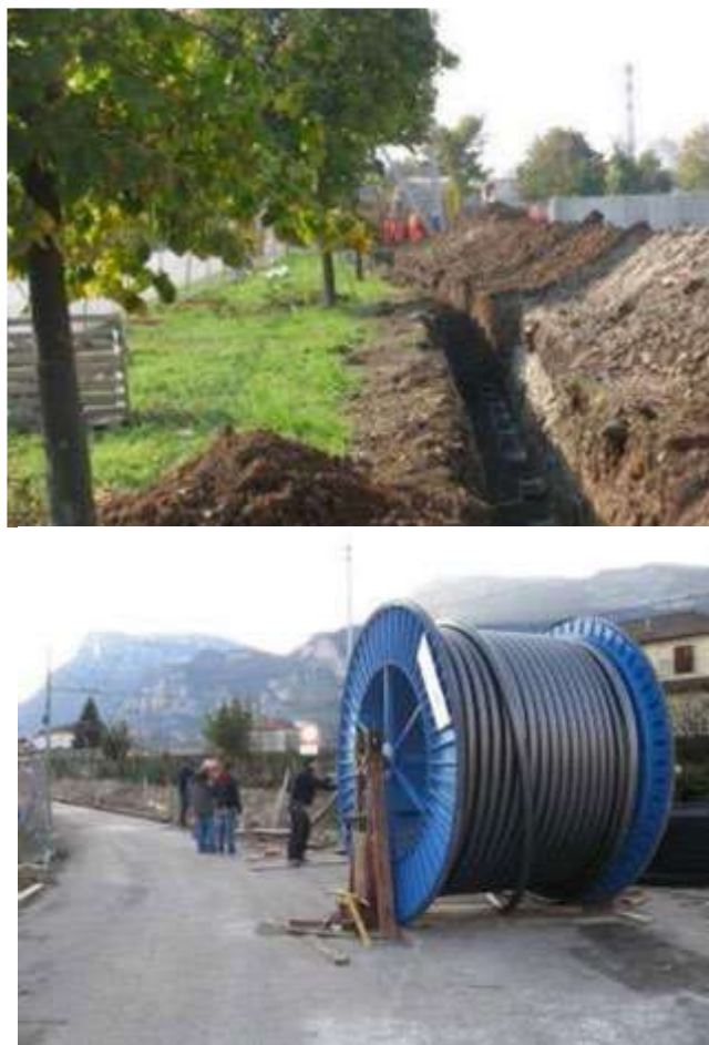
Figure 4 . 6: Exemple de pose de câble en tranchée
