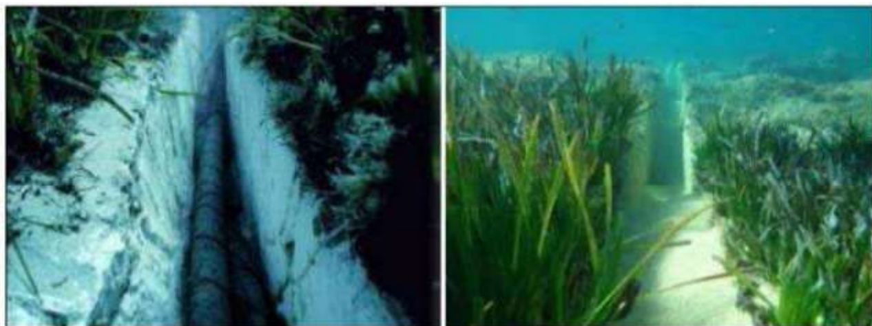
Figure 4 . 17: Tranchée sur Posidonia générée avec des engins de tranchées flottantes contrôlées
