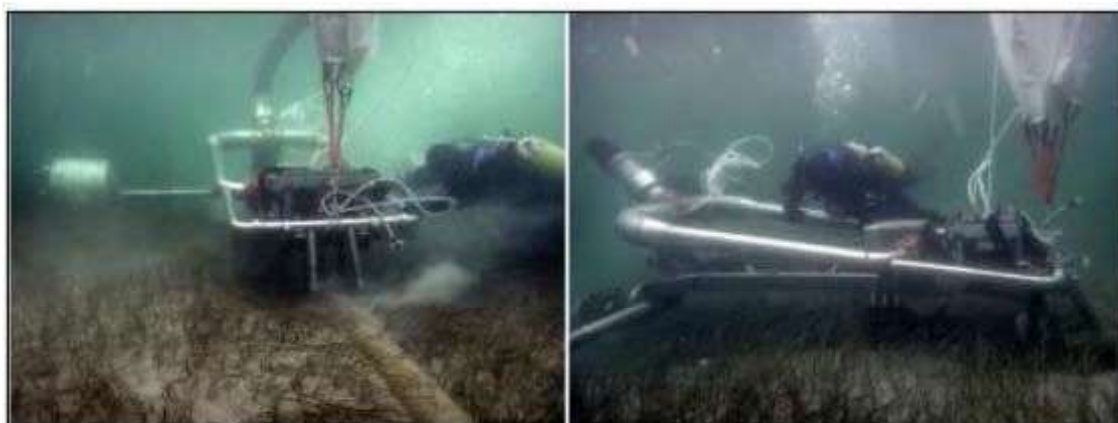
Figure 4.13: Engins de lançage sur Posidonia oceanica sur sédiments sableux
