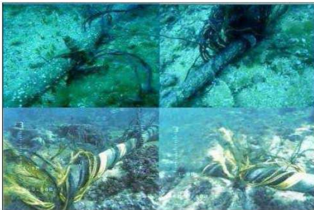
Figure 4.11: Câbles sous-marins non protégés endommagés par l'activité humaine
