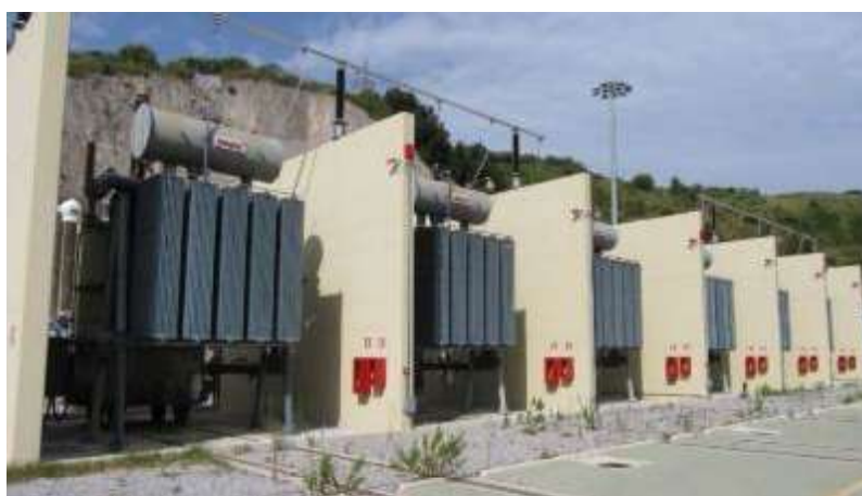
Figure 4 . 1: Fondations d'équipement monocœur
