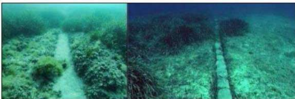
Figure 4.14: Tranchée sur Posidonia sur sable générée par une machine à jet
