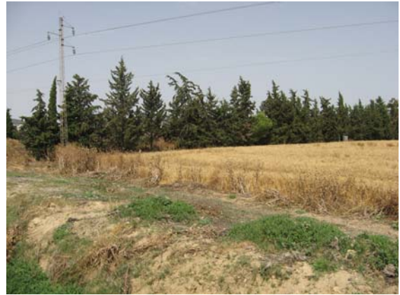
Photo 28 : Station d'arrivée du gazoduc
