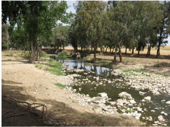
Photo 27 : Oued Béja au niveau du passage du gazoduc
