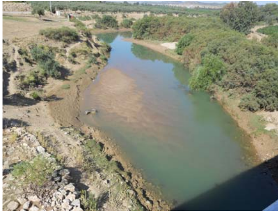
Photo 7a : Passage du gazoduc sous oued Mejerda
