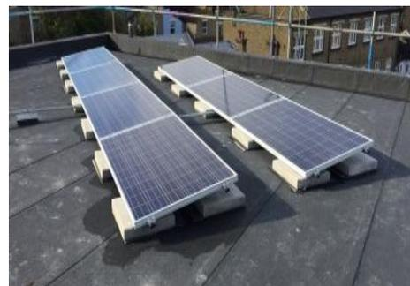
Figure 5: Châssis lestés sur une toiture
