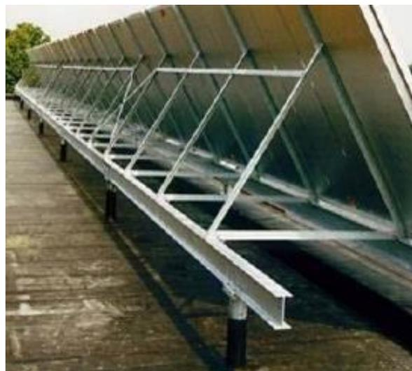
Figure 6: châssis ancré sur une toiture
